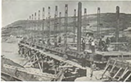
Nuri Demirağ'ın Erzurum Demiryolu çelik köprü inşaatı.
