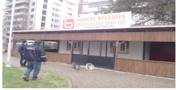
Şairler Parkı Belediyeler Birliği Çatı Yapım Çalışması
